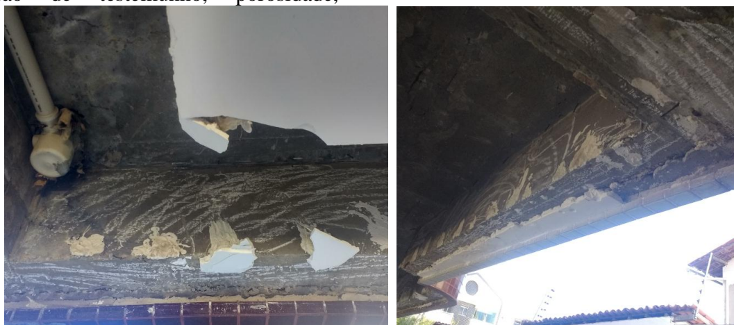
Figura 8 - Vigas “a” e “b” em estado de área de estado mínimo de corrosão, demarcada após teste de diferença de potencial nas áreas próximas aos focos de corrosão crítica.
