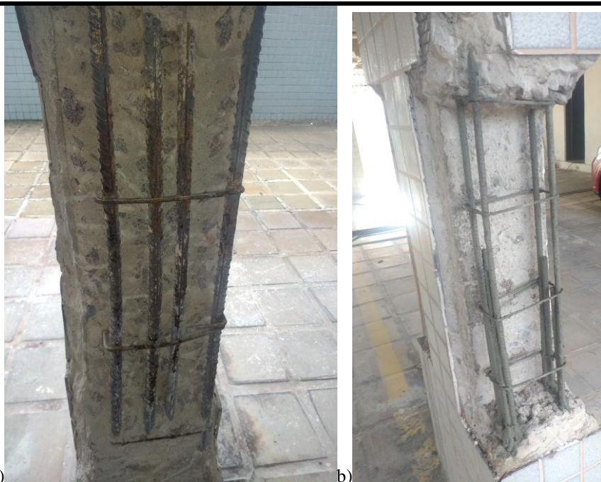
Figura 9: a) Estado de conservação do pilar encontrado na obra; b) Processo de recuperação de outro pilar, depois de retirado o concreto carbonatado, retirado à corrosão da armadura, passado pintura com anticorrosivo, esperando apenas o processo de recobrimento da armadura.
