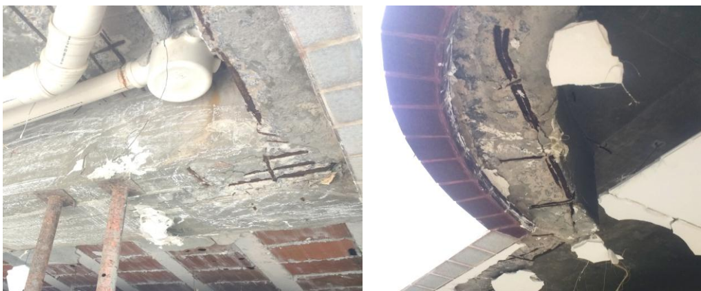
Figura 6 - Viga “a” e viga “b” em estado crítico de corrosão
