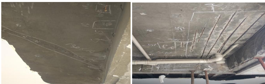
Figura 7 - Laje “a” em estado regular. Laje “b” em estado crítico
