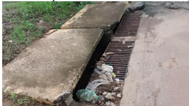
Figura 15 - Boca de lobo dupla cheia de lixo na Perimetral Rogerio L. S. Silva
