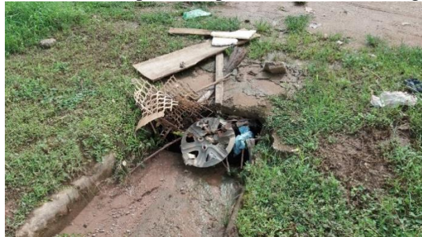
Figura 14 - Boca de lobo simples entupida na Perimetral Rogerio L. S. Silva
