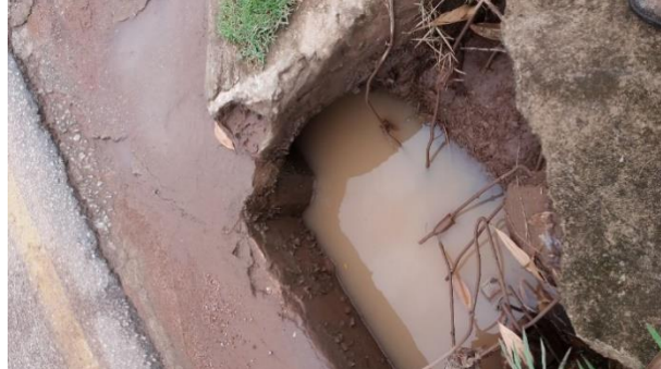
Figura 13 - Boca de lobo simples danificada na avenida Ariosto da Riva
