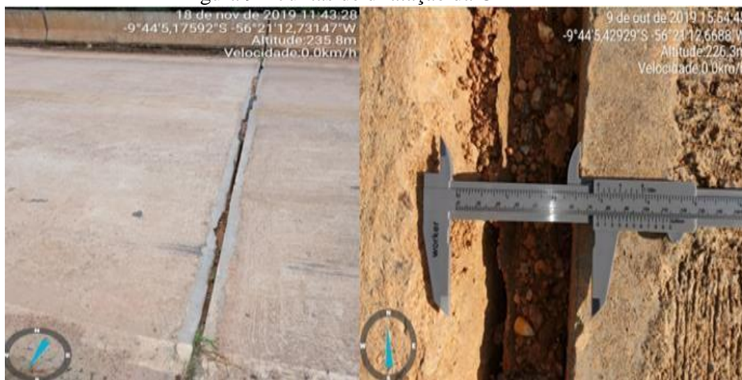
Figura 9 – Juntas de dilatação da OAE
