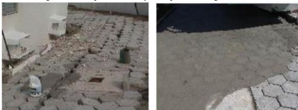
Figura 16 – Impermeabilização do piso com argamassa aditivada
