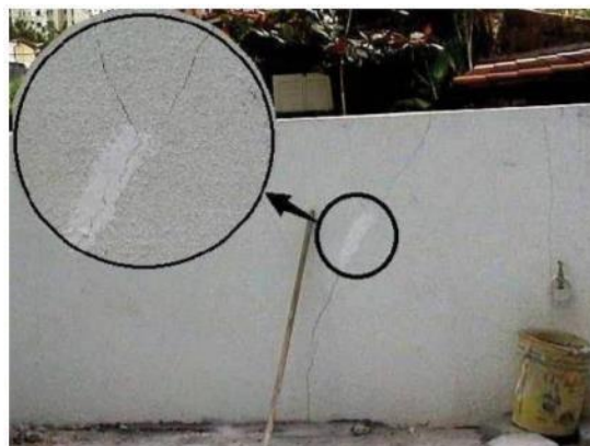
Figura 20 – Massa corrida sobre fissura no muro de divisa do terreno
