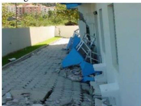
Figura 10 – Solo deformado
