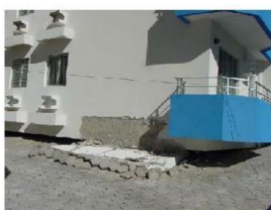
Figura 9 – Pilar-Parede caídos
