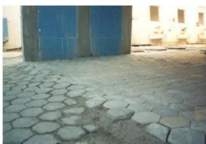
Figura 8 – Recalque do piso
